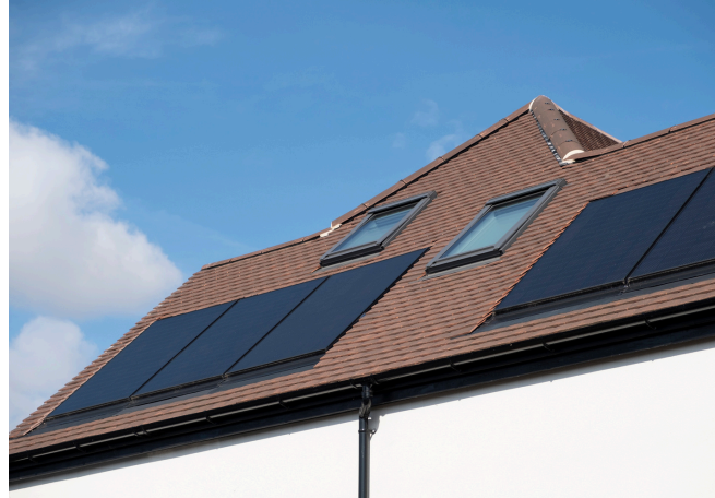
Solar PV array
